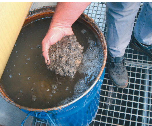
Ausgetragener Schlamm aus Kühlturmsystem
